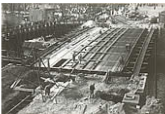
Neubau der Buschkrugbrücke, 1950
